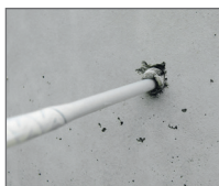
Naplňte cca 2/3 vyčištěného otvoru
