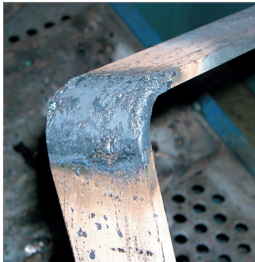
Povrch materiálu není poškozen.
